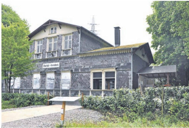
Rund um das schieferverkleidete, denkmalgeschützte Bahnhofsgebäude kehrt neues Leben ein – mit direkten Zugängen von der Nordbahntrasse.
